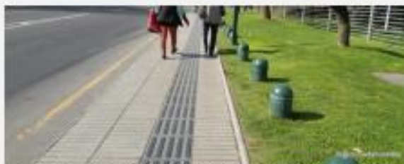
Foto 14 (izq) y 15 (der): El pavimento táctil bajo relieve presta una mejor función universal de circulación que el tradicional sobre relieve, incómodo para caminar sobre él, termina siendo evitado por los peatones provocando angostamiento del espacio útil de circulación.
