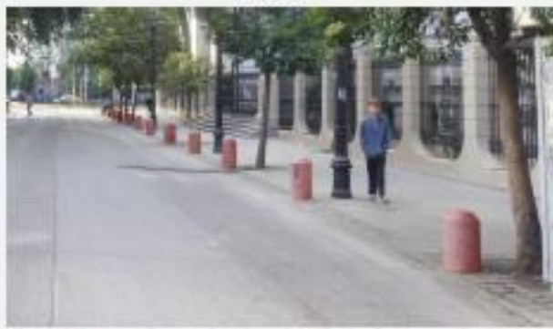
Foto 27: Vereda y calzada a igual nivel separadas por bolardos con contraste de color con el pavimento.
