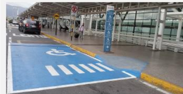
Foto 34: Estacionamientos para PcD paralelo y conectado a la vereda.
