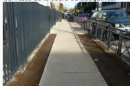
Foto 2: Vereda sin obstáculos y de pavimento estable, que conforma una ruta accesible en todo su ancho.
